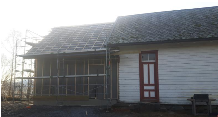
Bilete 4-5 . Renovering og utviding av Stavøy grendahus.
